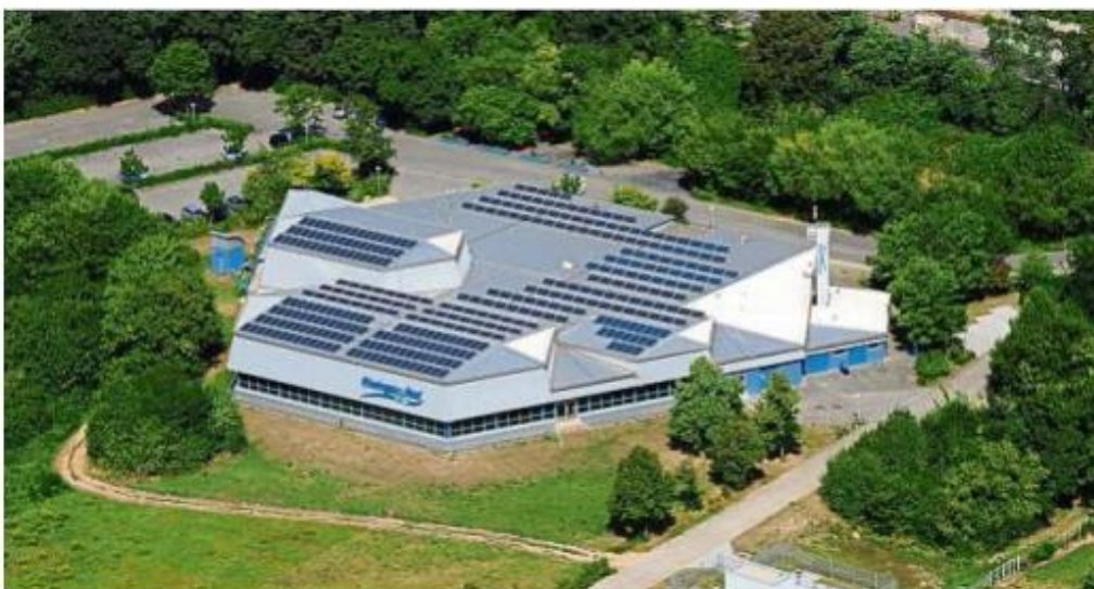
Das Rheingau-Bad soll von September an für rund ein Jahr schließen. In dieser Zeit sollen die maroden Becken eine Edelstahlauskleidung erhalten.
